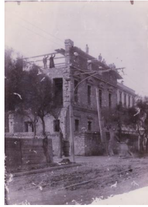
عمليات بناء المبنى الجديد
